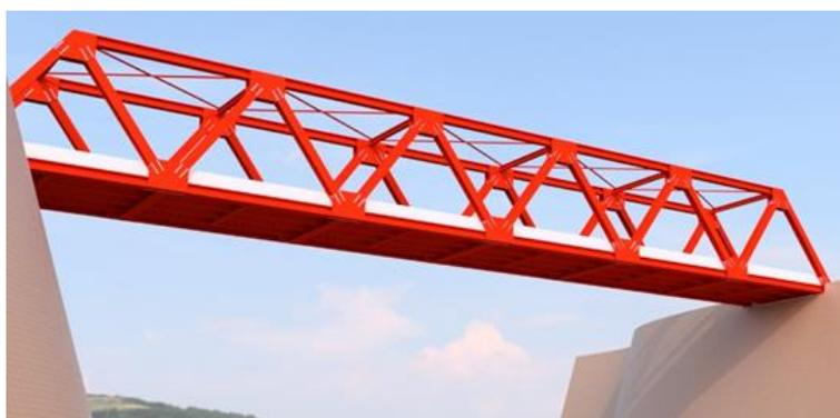
**Figura 01** - Vista da Ponte Treliçada em vão de 90m
