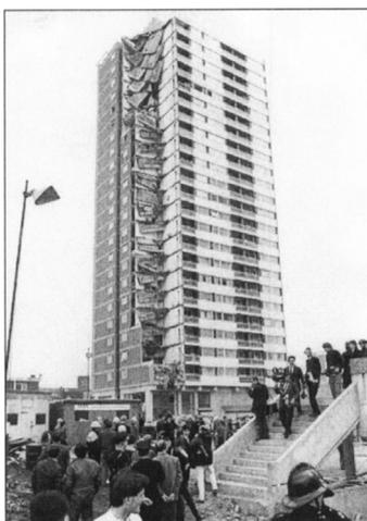
**Figura 1.1 – Edifício Ronan Point após colapso [4]**
