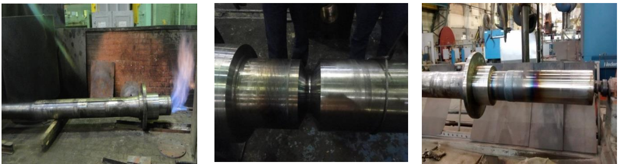
Figura 17: Montagem das partes a serem soldadas
